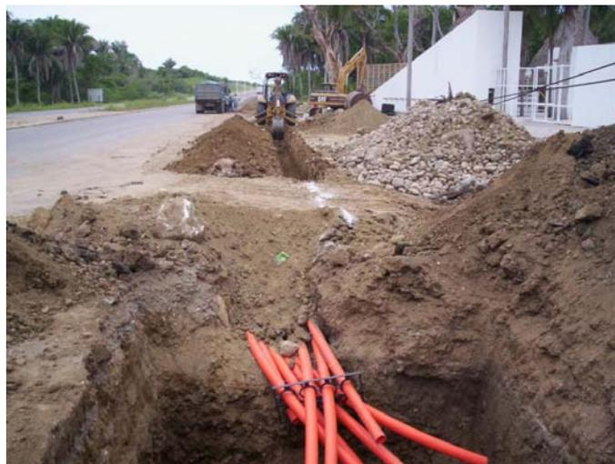
Figura 2. Instalación de ductos para canalización telefónica
